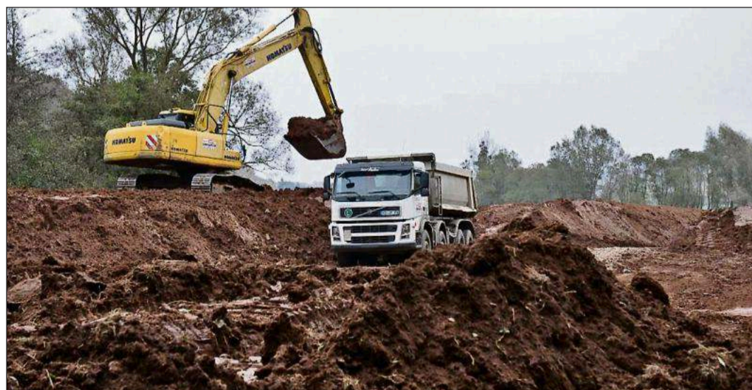
Bagger und Lkw in der Twiste-Aue zwischen Braunsen und dem Twistevorstau: Mit schwerem Gerät wird die Uferzone abgeflacht, damit der Bach sich besser ausbreiten kann. Dadurch verringert sich die Fließgeschwindigkeit. Schwebstoffe können sich hier absetzen und gelangen nicht als Sediment in den See. Foto: Elmar Schulten
