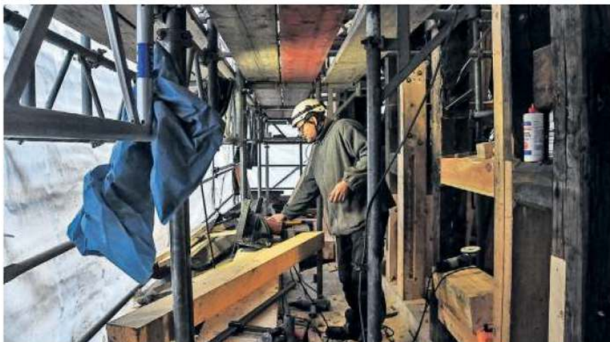
Auf den ersten Blick ist die Baustelle eine ganz normale – doch jenseits der Plane geht es mehr als 50 Meter in die Tiefe. Auf Höhe der Glockenstube sind die Handwerker derzeit mit dem Austausch maroder Balken beschäftigt.
