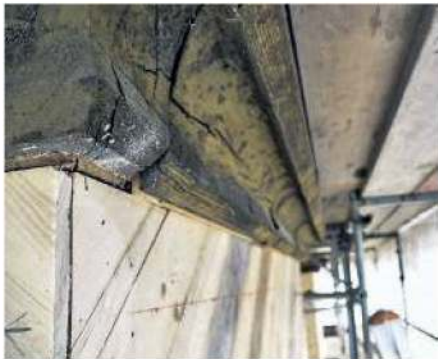
Alt und neu: Viele der Balken im Turm der Klosterkirche sind noch intakt. Die Verschalung wird komplett erneuert.
