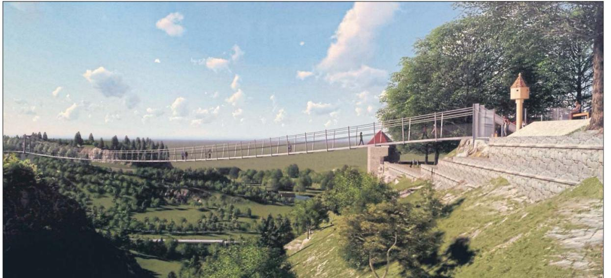
So könnte die mit 900 Metern längste Hängebrücke der Welt aussehen, sie soll von Rottweil aus über das Neckartal führen. Allerdings hängt sie nicht wie in Diemelsee vorgesehen frei, sondern wird mit zwei Pfeilern gestützt. Zeichnung: KTS Innovations/„Schwarzwälder Bote“
